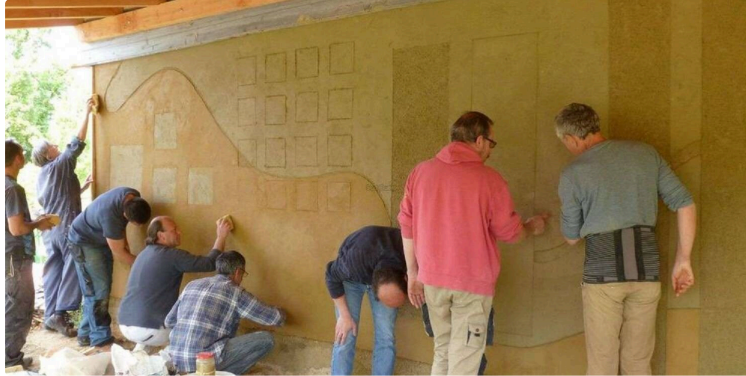
Les enduits de terre crue – l'Art des finitions
