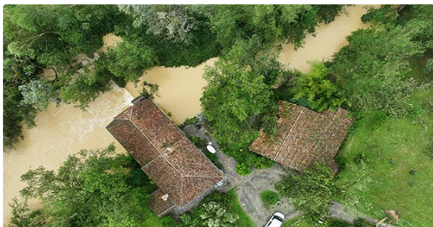
Le second épisode orageux provoque encore d'importants dommages
