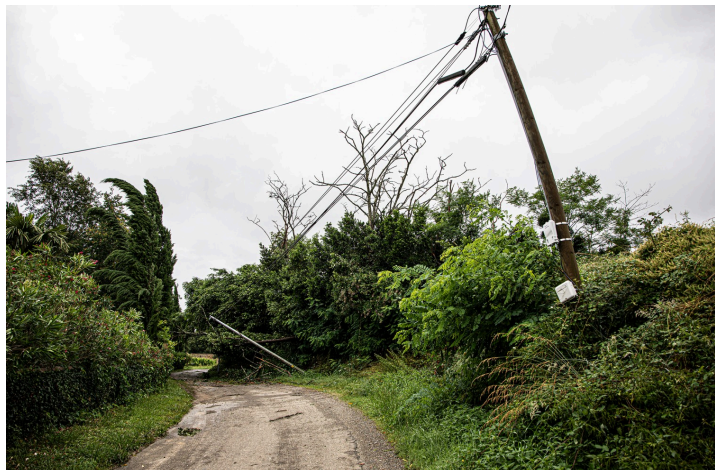
Vu de l'autre côté, le poteau métallique va être redressé
