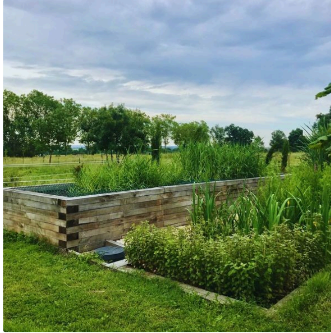
Assainissement des eaux usées de la maison par les plantes.
