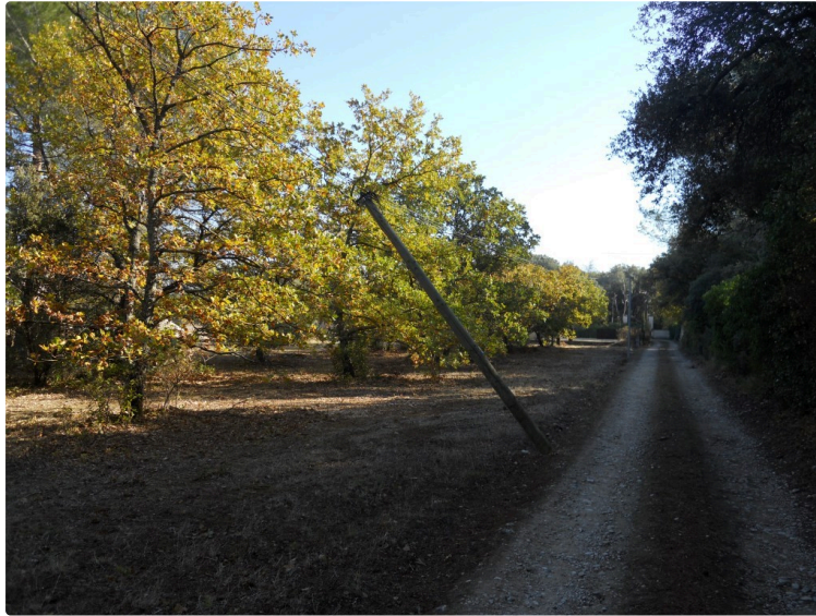
Après les intempéries, Orange remet ses poteaux sur pied
