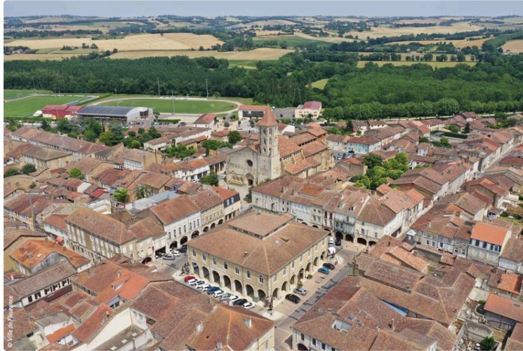
Des travaux de réfection de la voirie sont en cours à Fleurance
