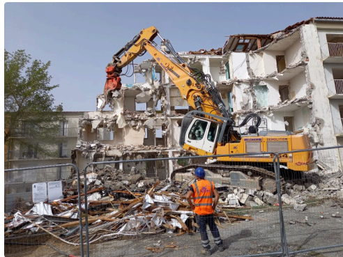
Démolition de la tour I.
