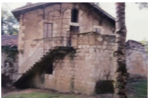
base médiévale du bâtiment du moulin-usine dit "de Barlet" - Beaucaire/Baïse
