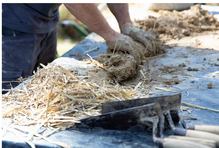
Fabrication d'un boudin de terre et de paille
