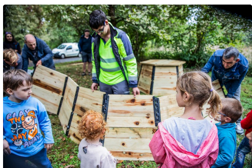
Montage d'un autre composteur
