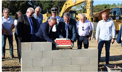
Du concret pour le futur centre de secours
