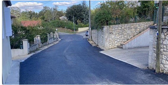
Les travaux de voieries avacent
