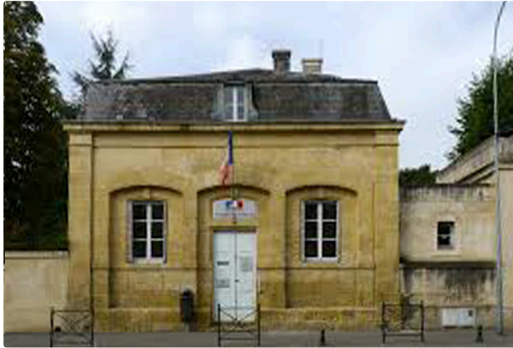
MIRANDE Nomination à la sous préfecture
