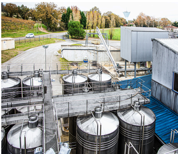
Vue sur les cuves les plus basses
