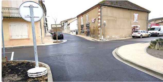
Les travaux s'achèvent
