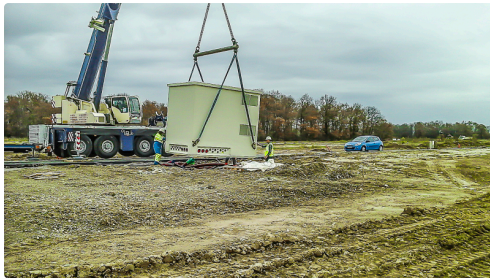
Mise en place d'un des transformateurs - Photo ERDF
