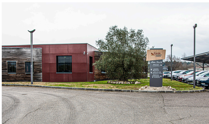
Le bâtiment des bureaux
