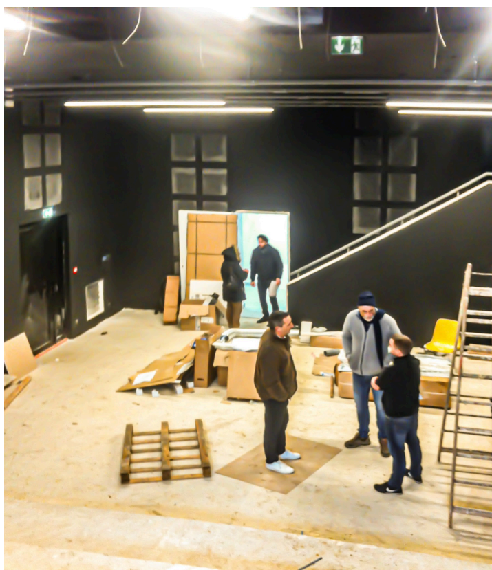
La future salle culturelle de l'Oustalet en travaux
