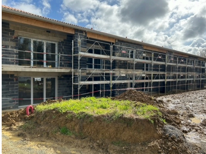
Vingt-quatre logements collectifs à loyer modéré mis en location début août
