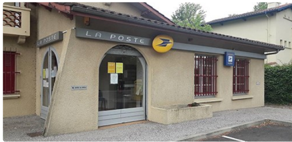
Fermeture temporaire du bureau de poste
