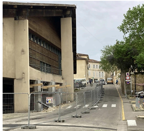
condom travaux 2.jpg
