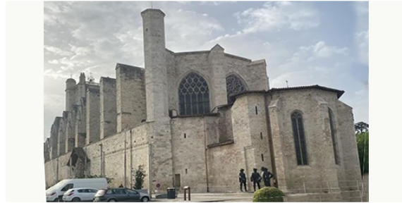
Cathédrale : Travaux et embellissements se poursuivent
