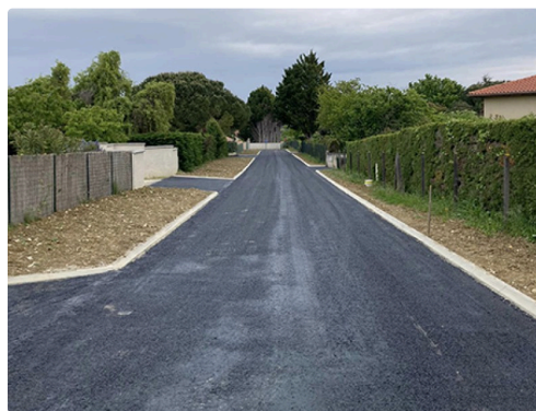
condom travaux 3.jpg
