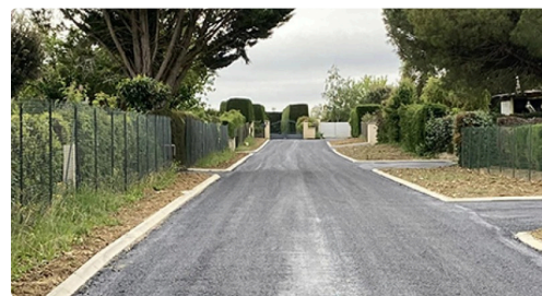
condom travaux 2.jpg
