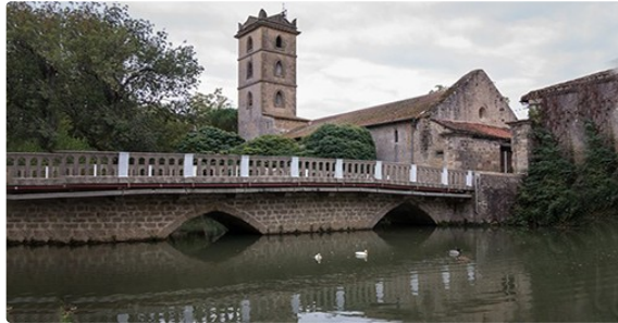
Surveillance de l'état des ponts
