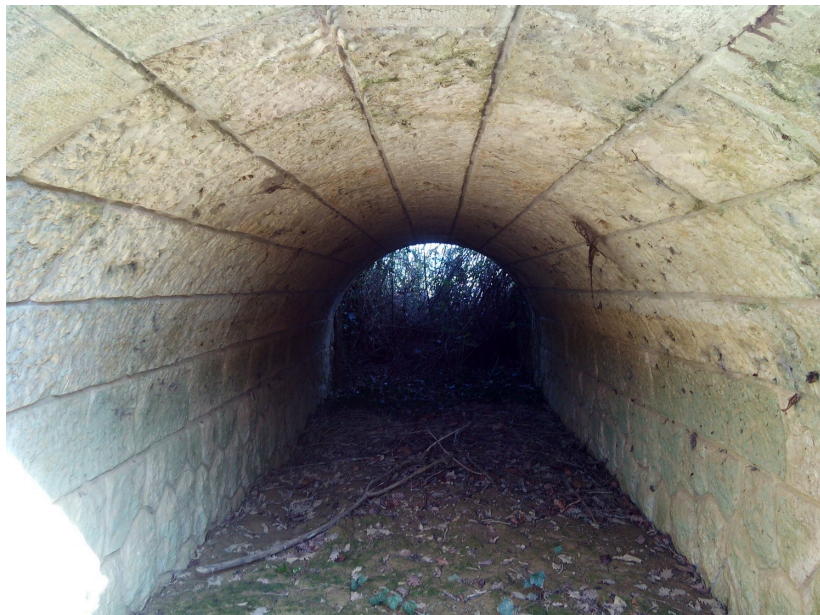
Ponceau voûté de 2 m PK 277 situé au nord de Pléhaut
