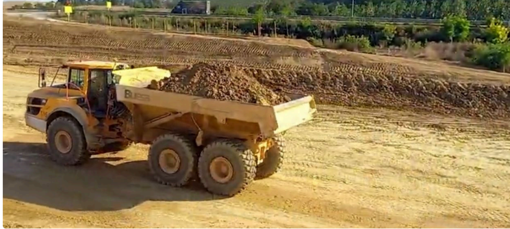
Le Département communique sur les travaux de la mise en 2X2 voies, Gimont-L'Isle-Jourdain
