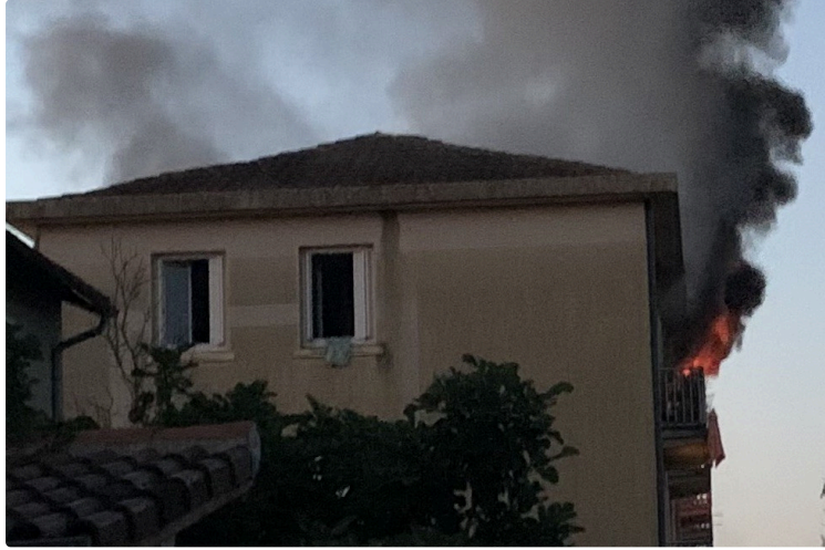
Un appartement ravagé par le feu
