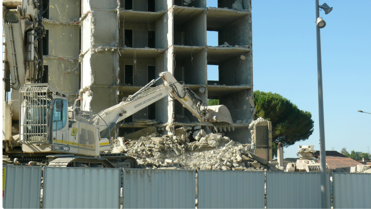
Déconstruction de la tour Athos
