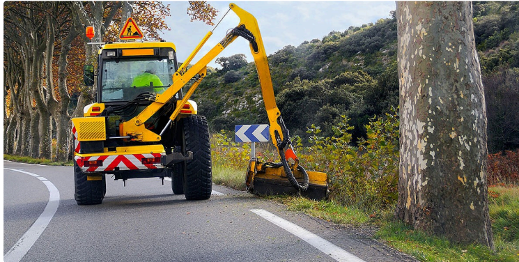
chantiers de débroussaillage sur les RN124 et RN21
