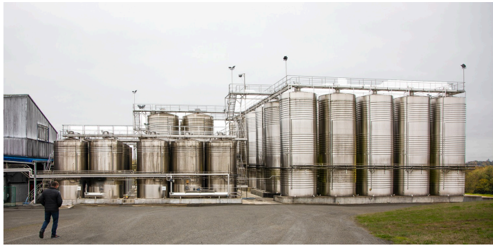
La cuverie construite en 2018
