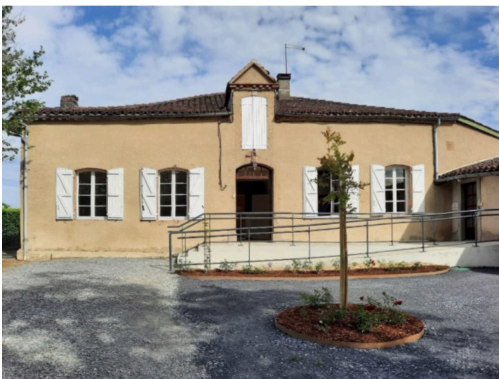
La bibliothèque municipale de Panjas (photo mairie de Panjas)
