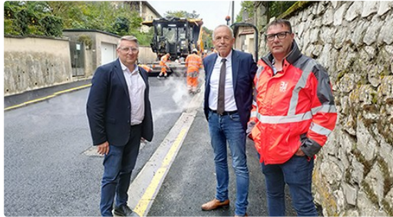
Rénovation de la voirie chemin du Barrail
