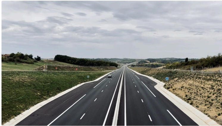
Le député Jean-René Cazeneuve communique : « Je m'oppose au moratoire pour stopper les travaux de la RN124 »
