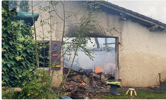
Une maison totalement détruite par un incendie
