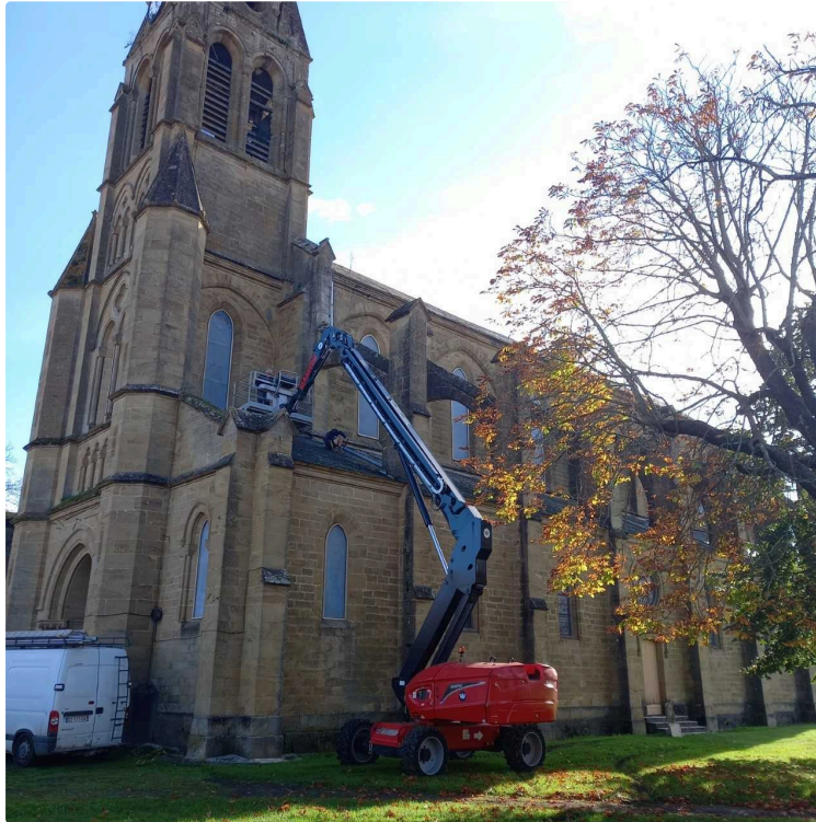
Des travaux sur le toit de l'église
