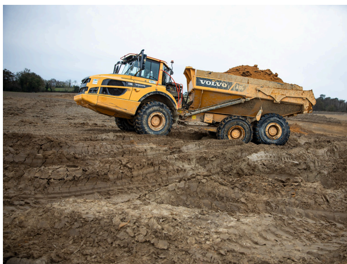
Une benne tout-terrain transporte de la terre
