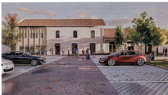
Vue du projet côté ville (image créée par l'atelier d'architecture Airoidi)
