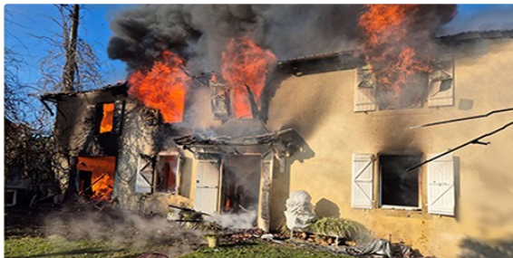
Une maison détruite par un violent incendie
