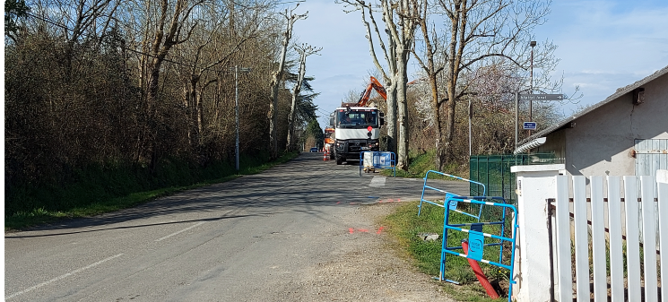
Travaux route d'Eauze : fermeture d'une portion de la route
