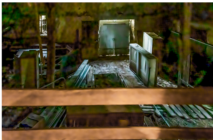
La salle culturelle avant son aménagement
