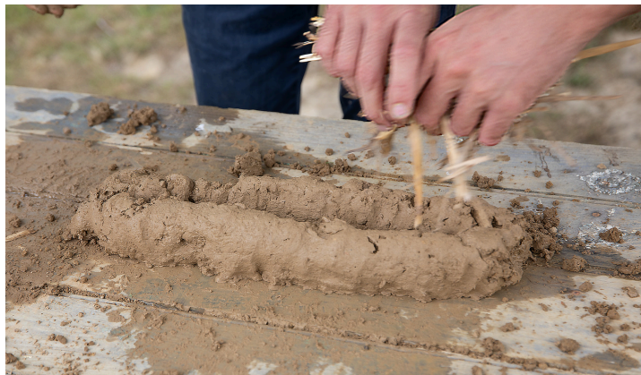
Une large fente est pratiquée dans le pain d'argile, une fois moulé, pour faire de la place à la paille
