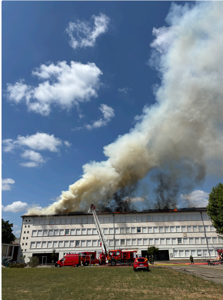
Collège Hubert Reeves de Fleurance : 500m 2 de toiture détruits lors d'un incendie ce dimanche
