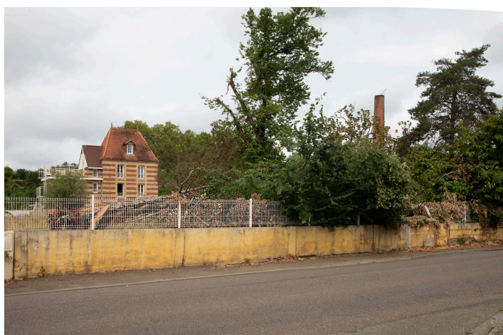
Dégâts avenue des Pyrénées
