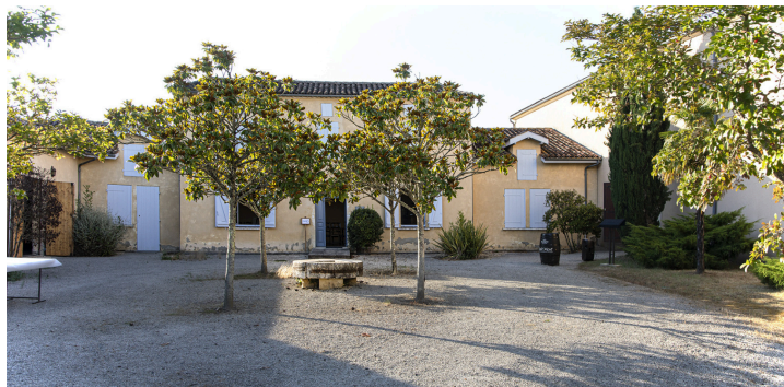
Vue d'une partie du site du Château de Saint-Gô
