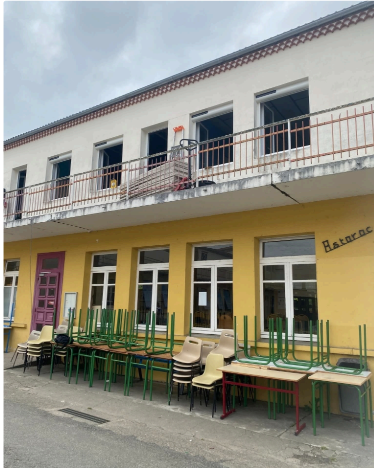
Gros travaux d'envergure durant les vacances
