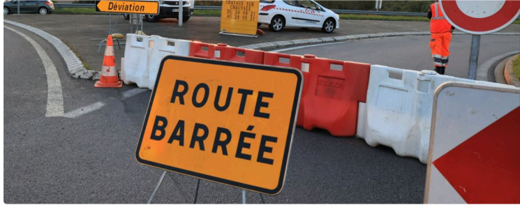
RN 124 : travaux au rond point de Saint Cricq de 21 h à 6 h
