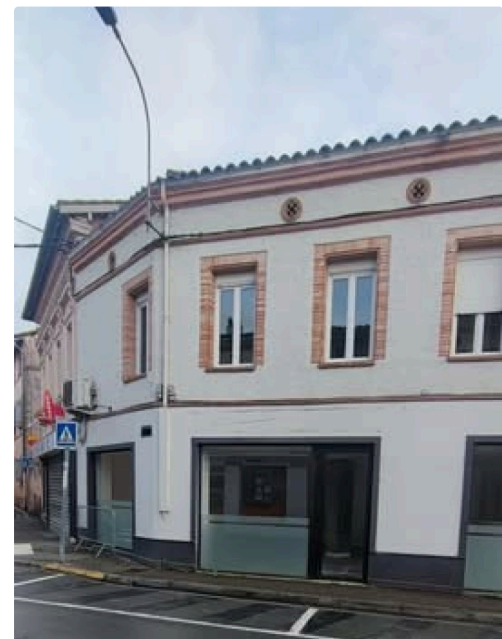
Octopus avant aménagement extérieur
