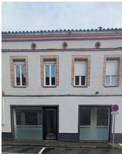
Octopus avant aménagement extérieur
