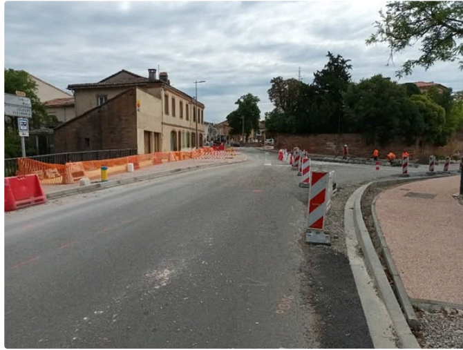
Information chantier : carrefour Saint Bertrand
