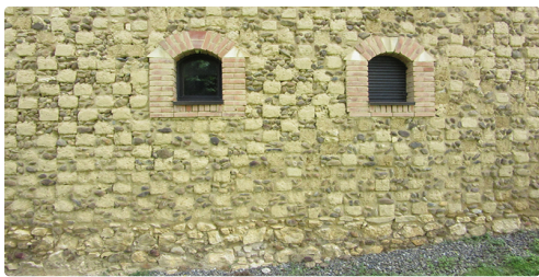
murs en samiers 1.jpg
