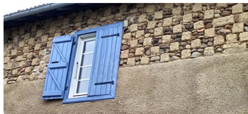
murs en damiers 4.jpg
