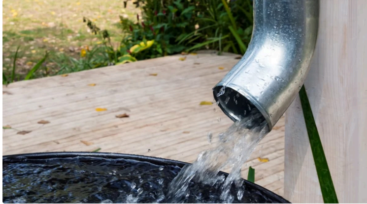
Distribution de récupérateurs d'eau de pluie
